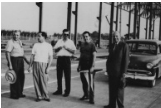
Visite de Charles Schneider (à dr.) sous les premières structures en 1956.
